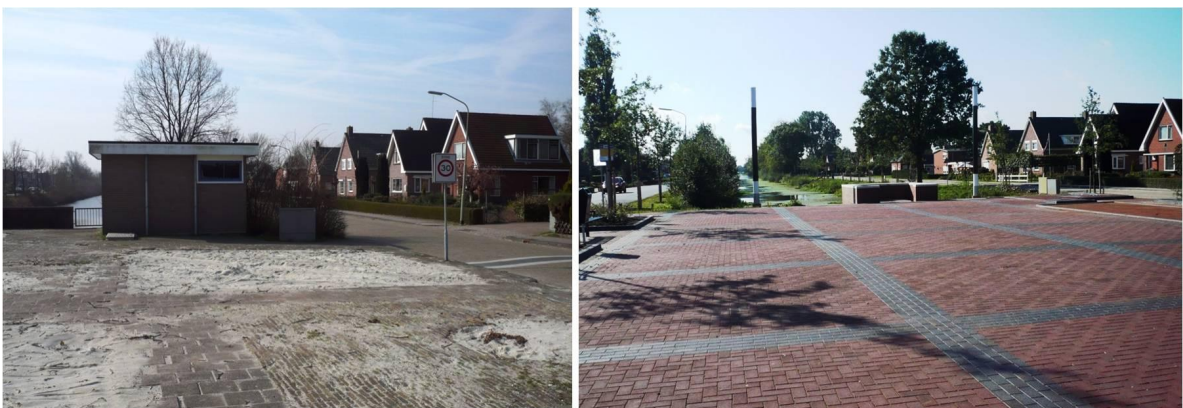
De Dam in Barger–Compasuum links met en rechts zonder pompgebouw
